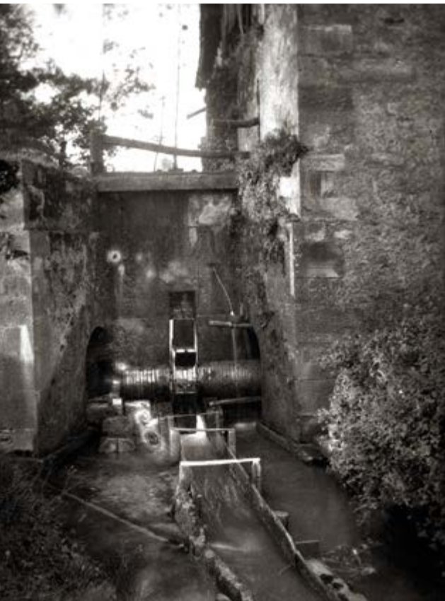
📷 Detalle de la turbina de la Ferrería de Lebario en Abadiño. 1925. Autor desconocido. F/003491. © Euskal Museoa. Bilbao.
